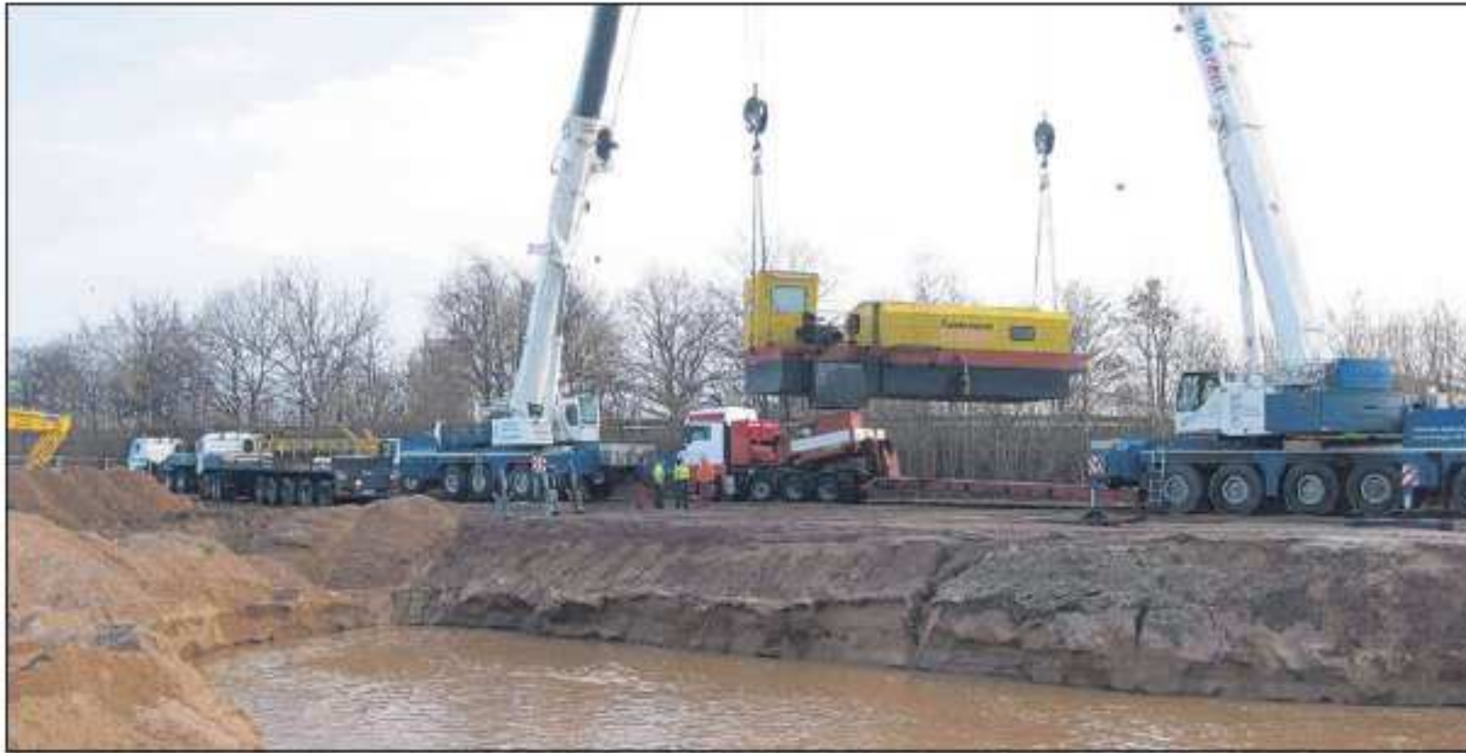
Schweres Gerät kommt beim Einsetzen des Saugschiffes in den neuen Baggerteich zum Einsatz.
