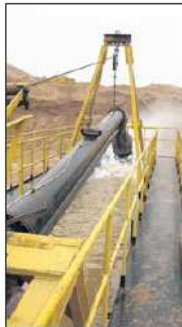
Der Saugrüssel taucht in den neuen Baggerteich ab.
